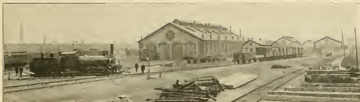
Abb. 401. Heizhausanlage [gerade] auf dem Wiener Central-Bahnhofe der Staatseisenbahn-Gesellschaft. [Nach einer Original-Aufnahme von A. Stempf.]
